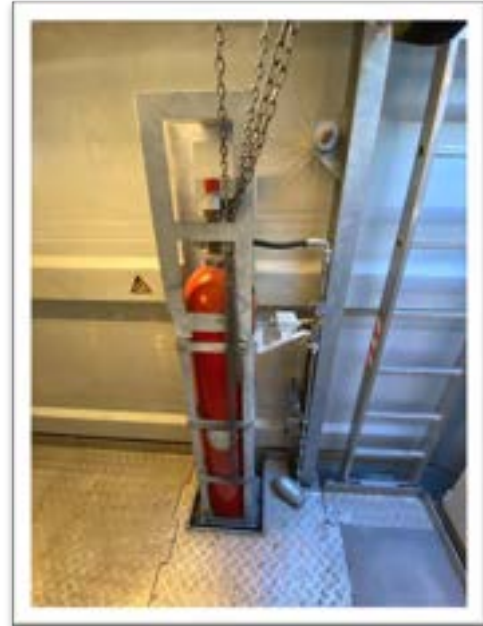
Şekil 5.43 Nasel için Yangın Söndürme Sistemi
