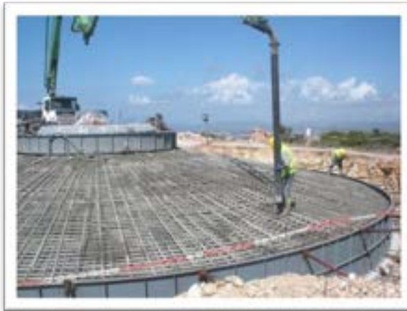
Şekil 6.11 Rüzgâr Türbini Temel Betonunun Dökümü
