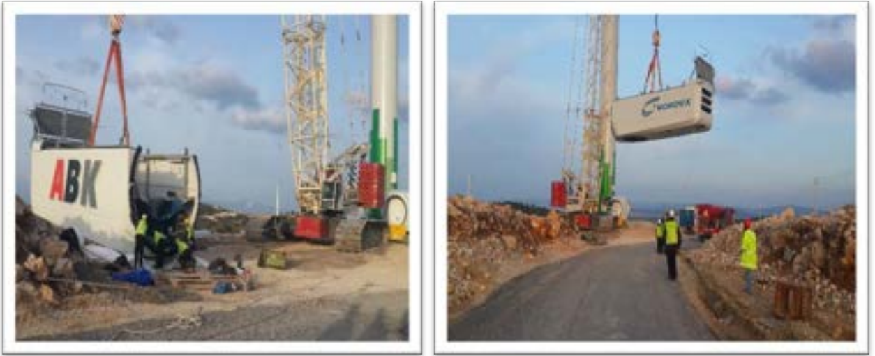
Şekil 6.39 Nacelle Montajı
