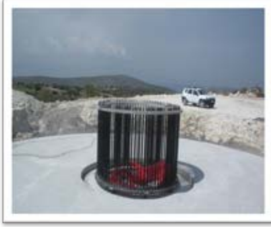
Şekil 6.9 Rüzgâr Türbini Taban Ankrajı
