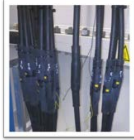
Şekil 7.6 Termal Kamera ile İnceleme İşlemleri
