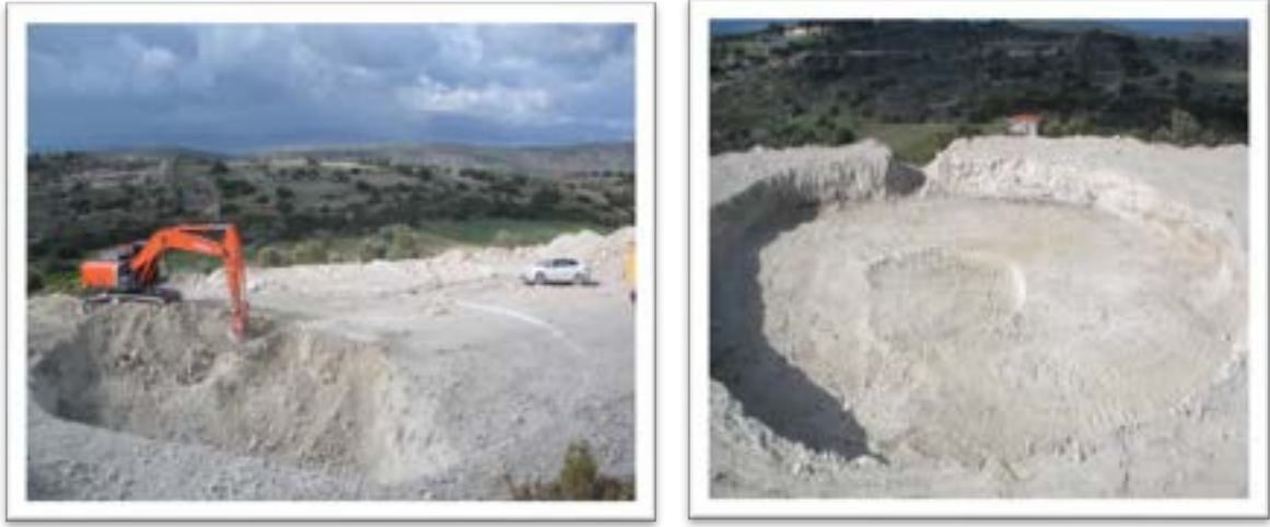
Şekil 6.7 Türbin Temeli Kazı İşlemi
