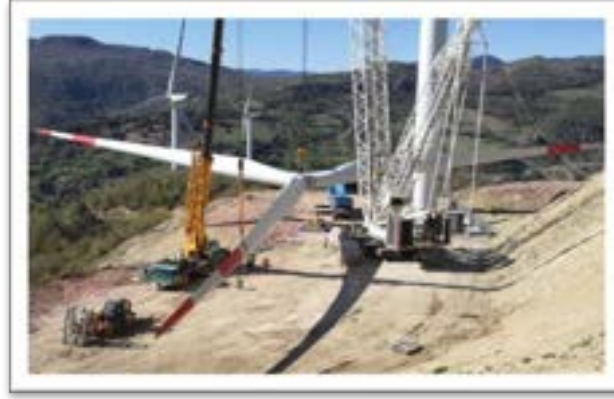
Şekil 5.49 Kanat Kurulumu
