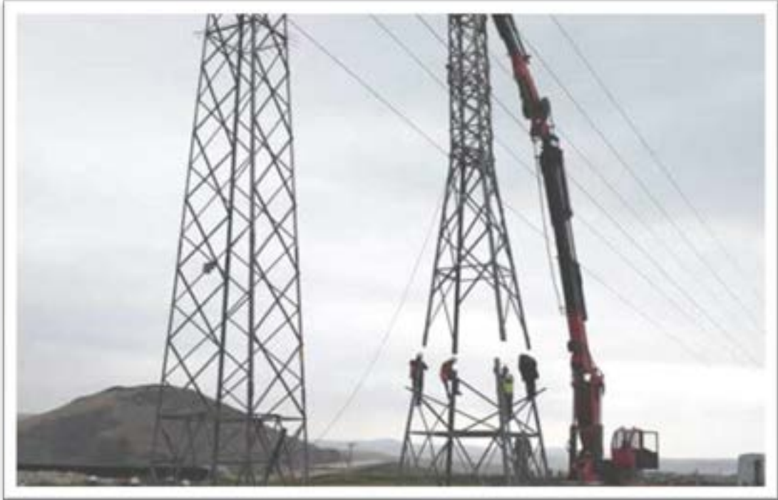
Şekil 6.45 ENH Direği Montajı
