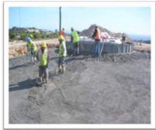
Şekil 6.11 Rüzgâr Türbini Temel Betonunun Dökümü
