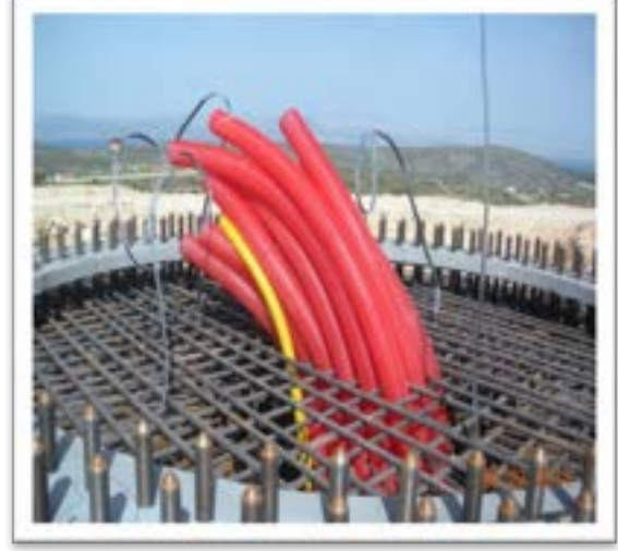
Şekil 6.10 Rüzgâr Türbini Temeli Demir İşlemleri
