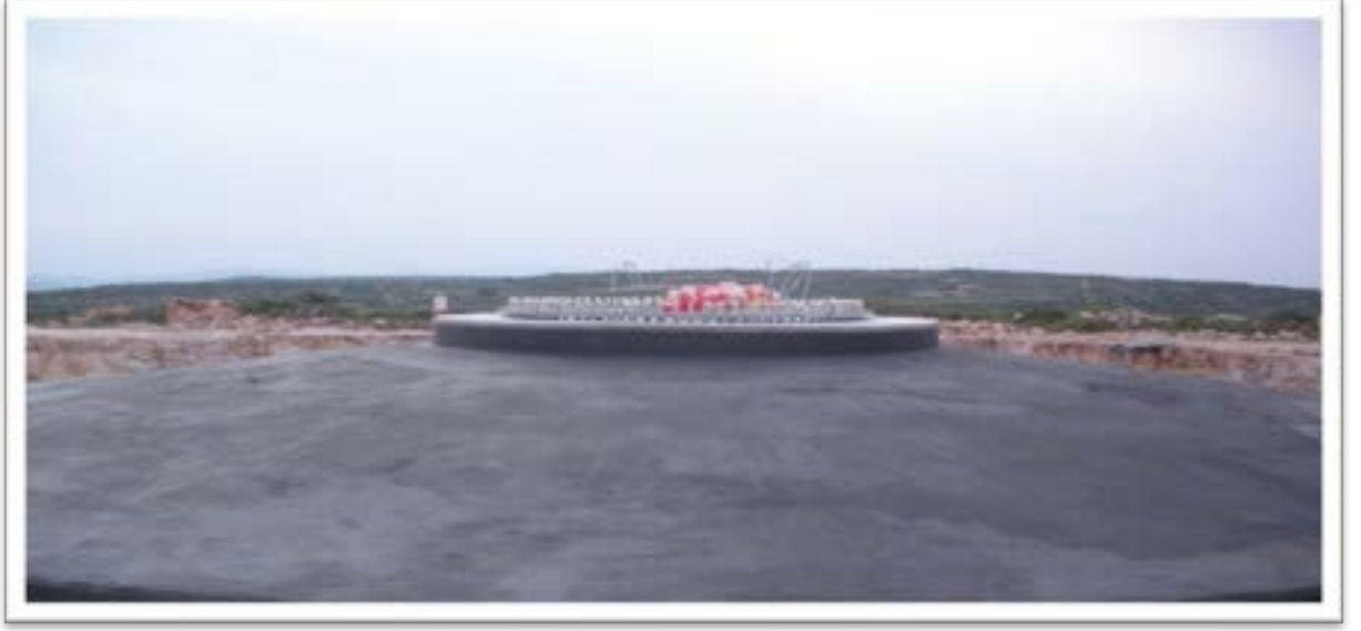
Şekil 6.12 Beton Dökümü Tamamlanmış Türbin Temeli
