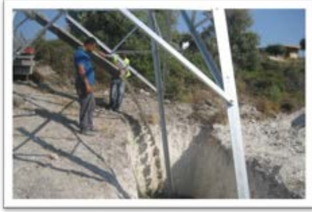
Şekil 6.44 Enerji Nakil Hattı Direklerinin Beton Dökülerek Sabitlenmesi
