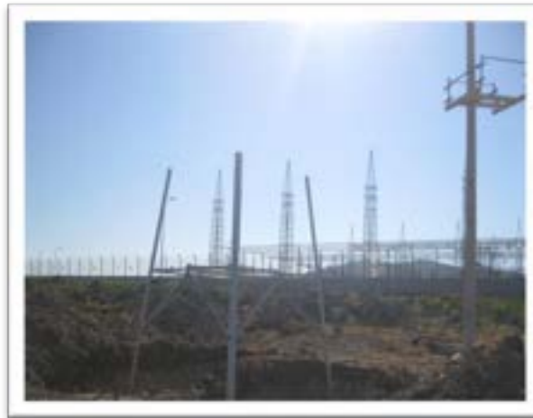
Şekil 6.43 Enerji Nakil Hattı Direklerinin Yerleştirilmesi
