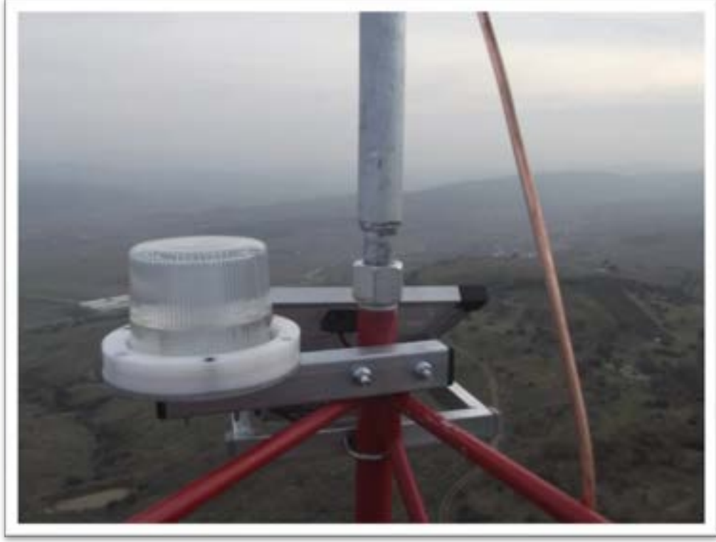
Şekil 2.11 Ölçüm Direğinde Kullanılan İkaz Lambası
