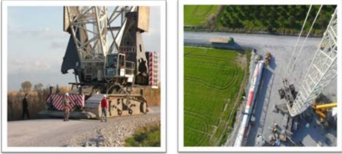
Şekil 6.17 Vinç Çalışma Sahasının Yapımı
