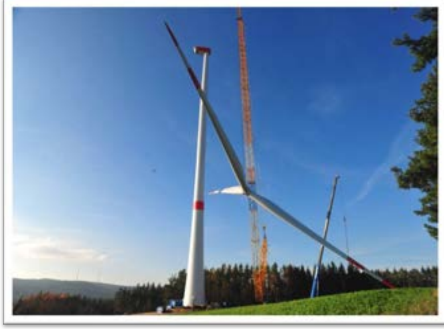
Şekil 6.41 Yıldız Montajı Gerçekleştirilen Bir Rüzgâr Türbini
