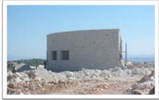
Şekil 6.14 Şalt ve Kontrol Binası İnşası
