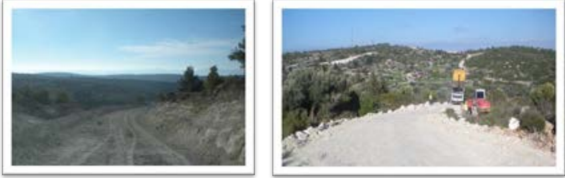
Şekil 6.2 Saha İçerisinde Yapılan Yol Çalışmaları
