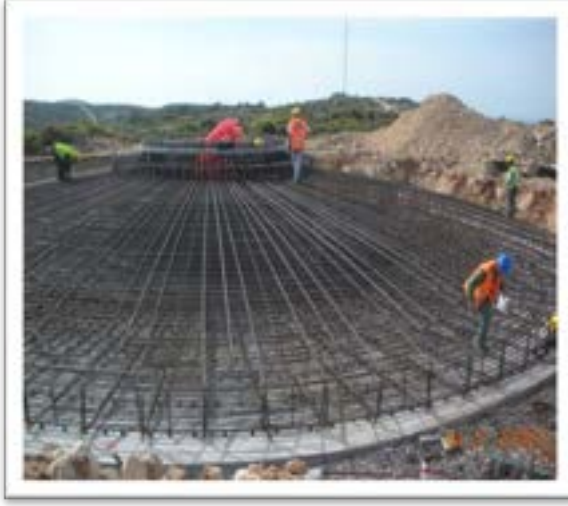
Şekil 6.10 Rüzgâr Türbini Temeli Demir İşlemleri
