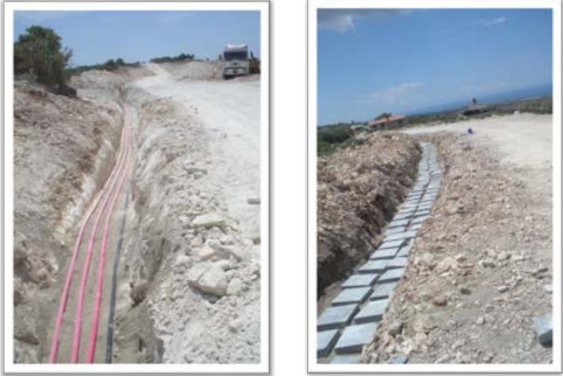
Şekil 6.16 Kablo Kanalı Yapımı
