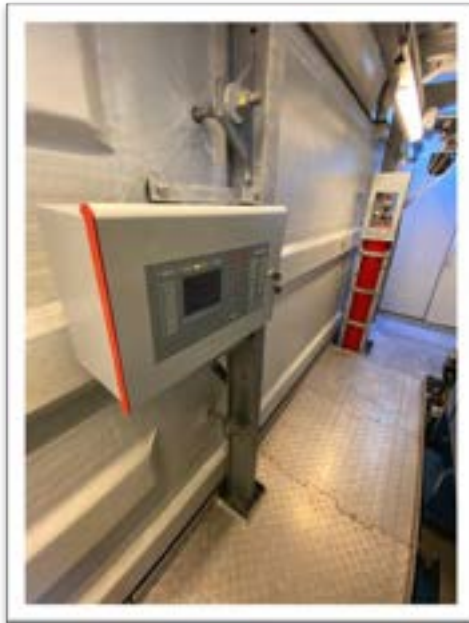
Şekil 5.43 Nasel için Yangın Söndürme Sistemi
