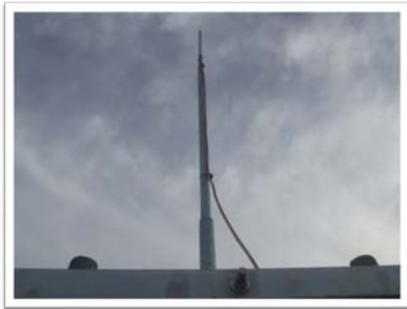
Şekil 2.12 Ölçüm Direğinde Kullanılan Paratoner
